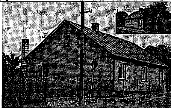
Rutki, gm. Rutki. Budynek mieszkalny, ul. Łomżyńska 30.
