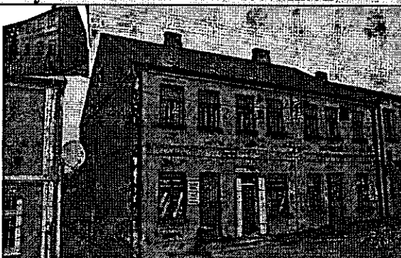
Rutki, gm. Rutki. Budynek mieszkalno-usługowy, ul. Rynek 6a.
