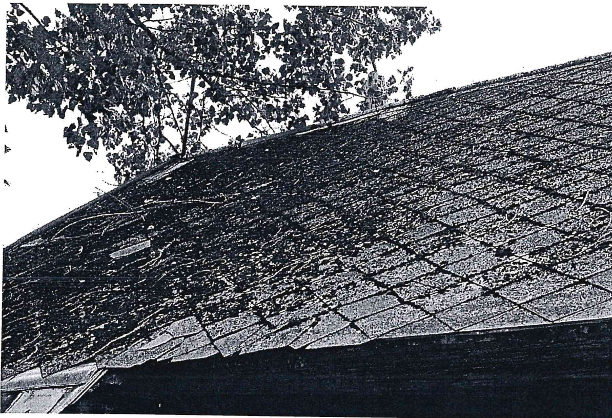
Fot.2. Przykład pokrycia dachowego z użyciem płyt zawierających azbest typu "karo", gmina Rutki.
